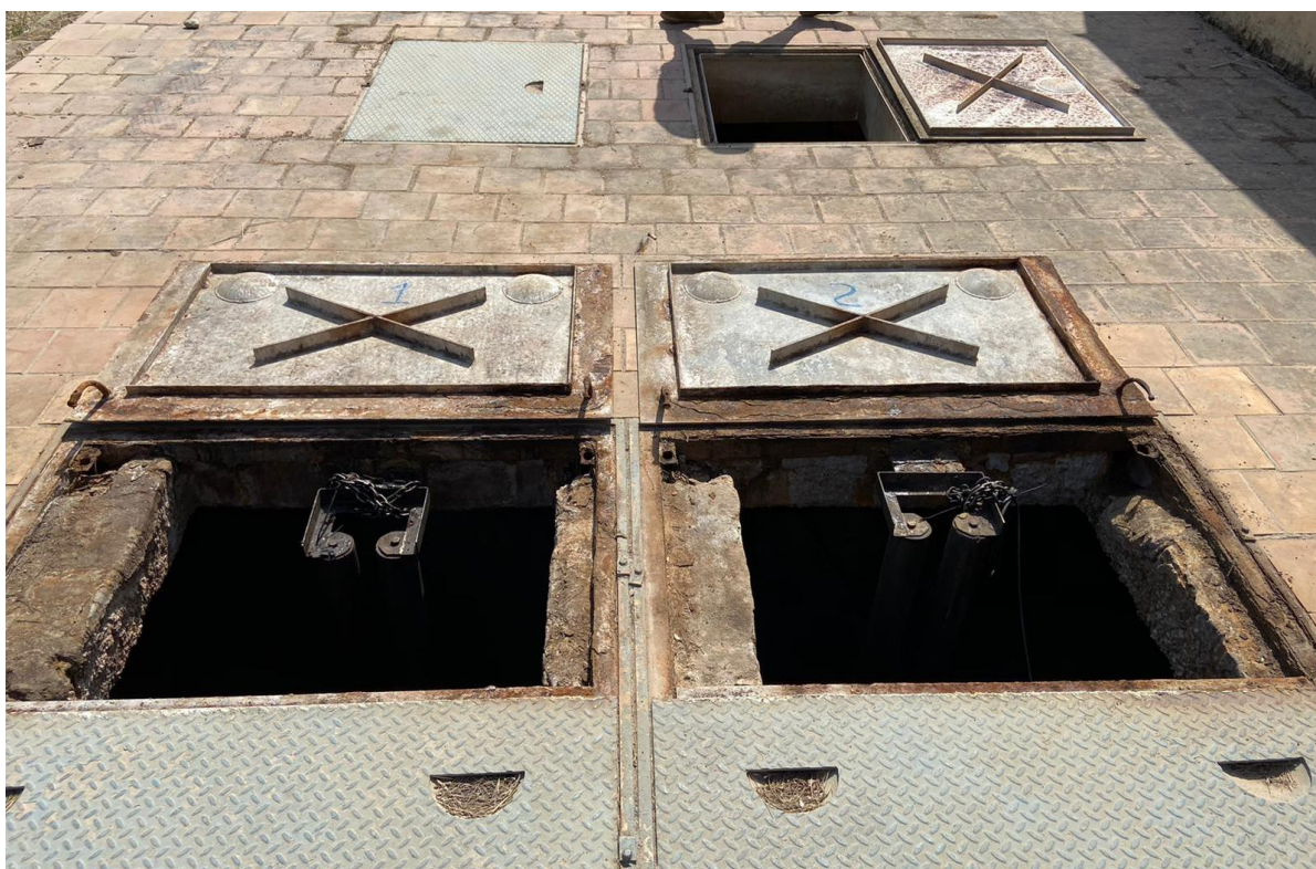
Imagen 9. Pozos de succión (abajo) e impulsión (arriba) de la EBAR
