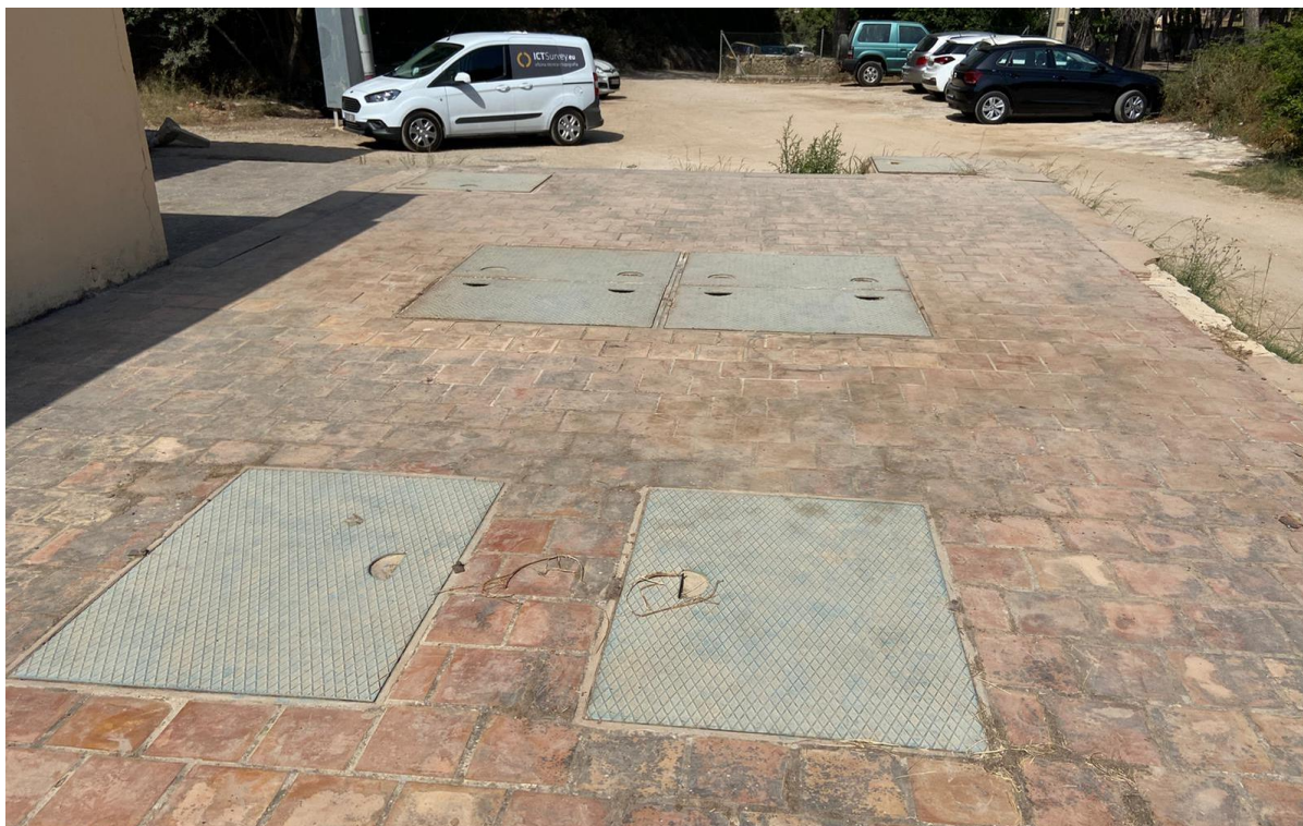
Imagen 8. Pozos de succión (arriba) e impulsión (abajo) de la EBAR
