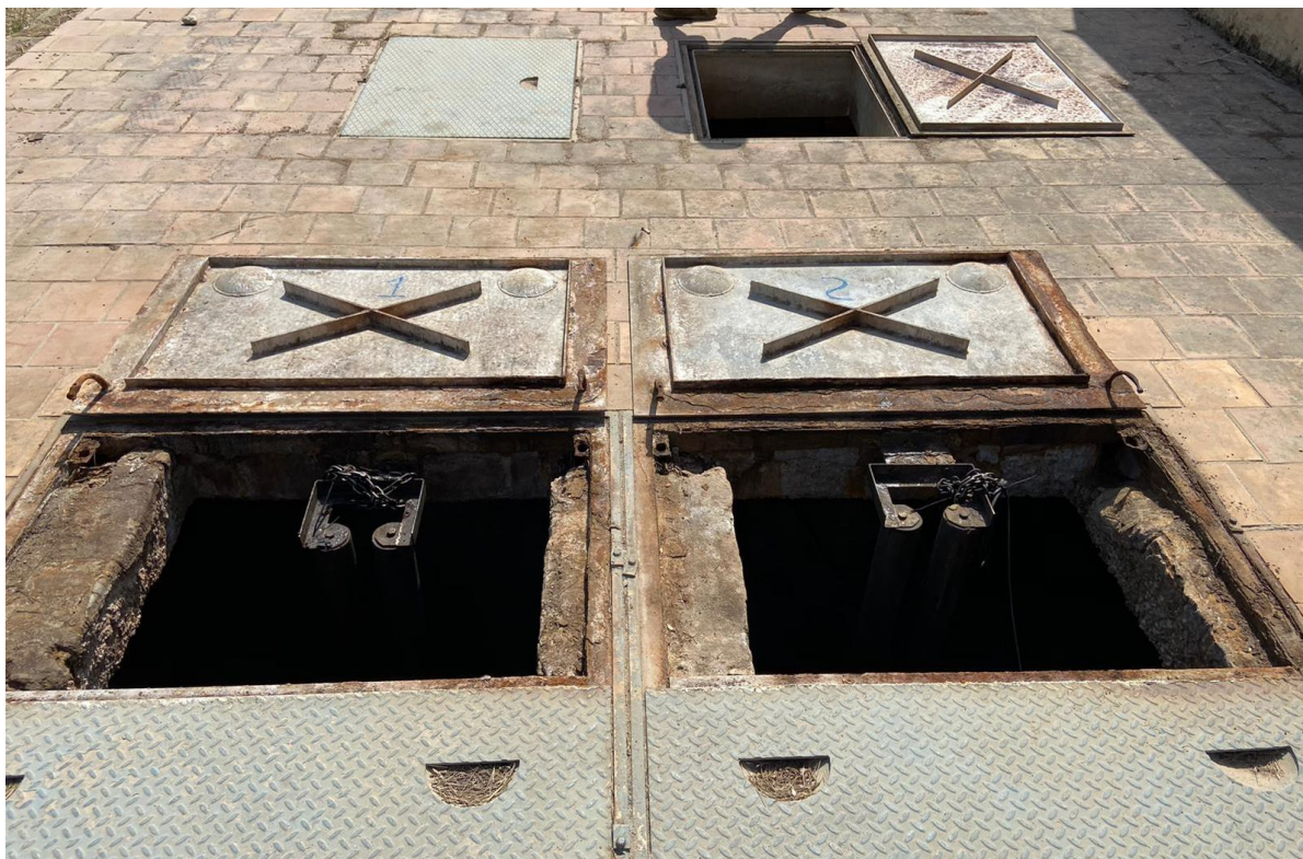
Imagen 7. Pozos de succión (abajo) e impulsión (arriba) de la EBAR
