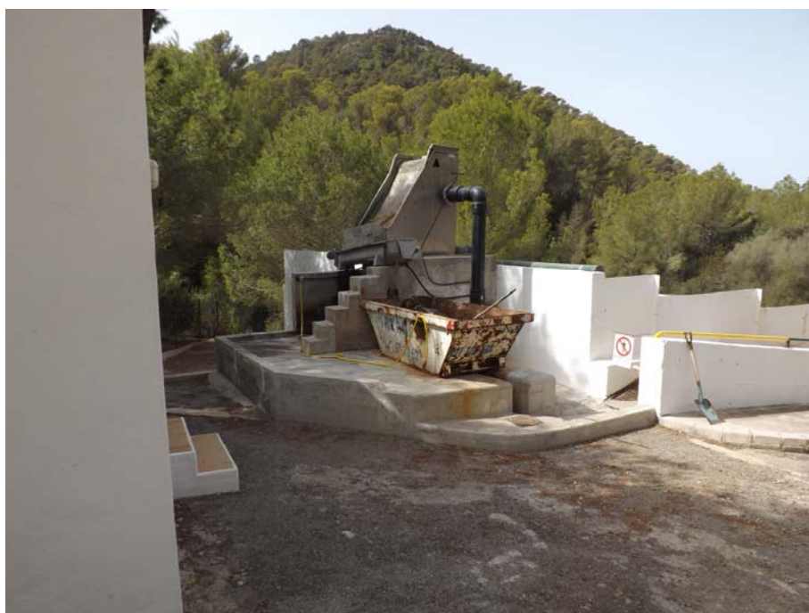
1. Instalación de tamizado de sólidos existente
