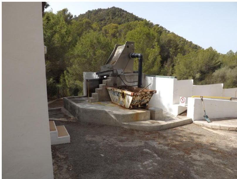
Fotografía 9. Sistema de cribado de las infraestructuras de depuración actualmente existentes en el ámbito de proyecto.
