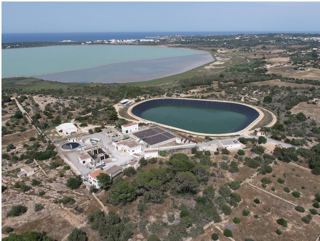
Vista aérea de la EDAR
