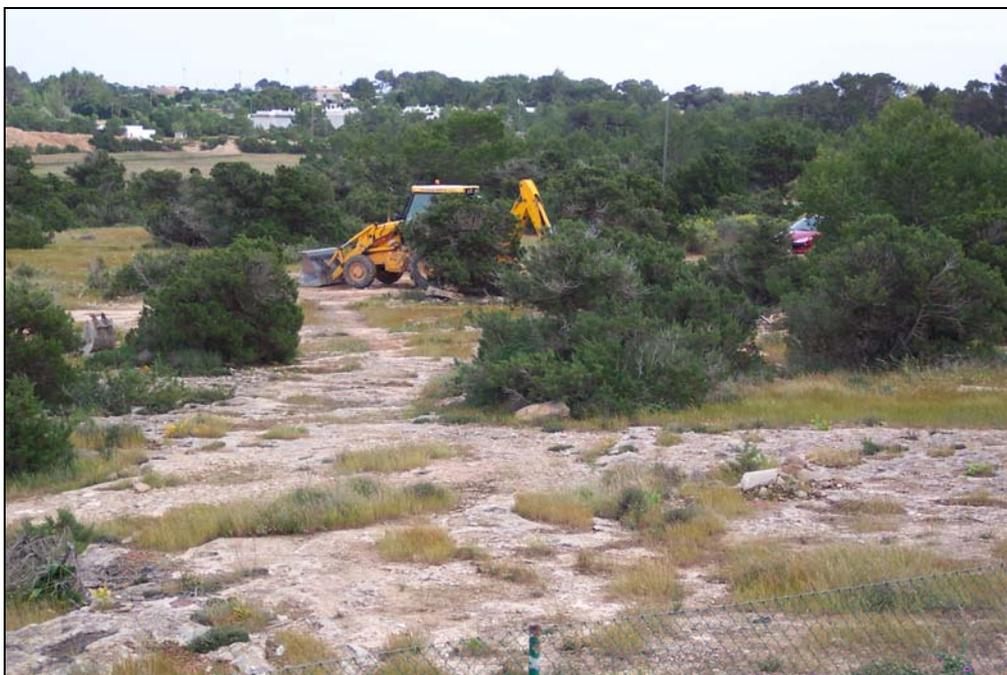
**Fotografía 4. Material calcarenítico aflorando. Al fondo máquina retroexcavadora realizando la calicata C-1**
