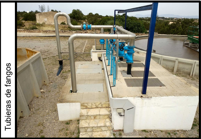
Válvulas de retención y compuerta
