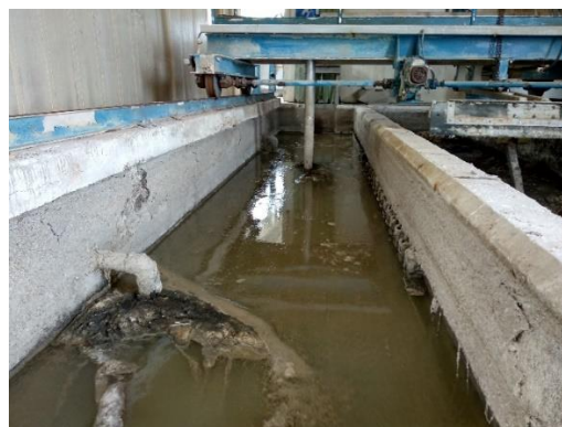
Canal de desarenado
