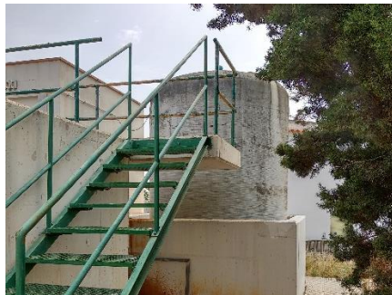
Deposito sulfato férrico
