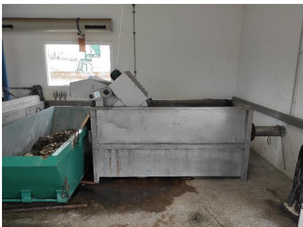
Desbaste de fosas sépticas
