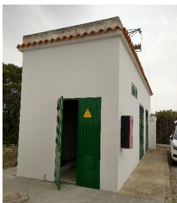
Centro de transformación
