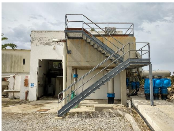
Obra de llegada
