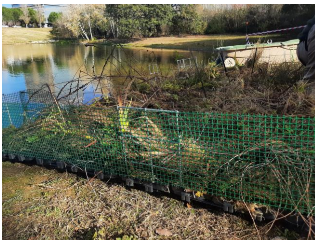
Figura 8 Sistema de protección perimetral de la isla flotante
