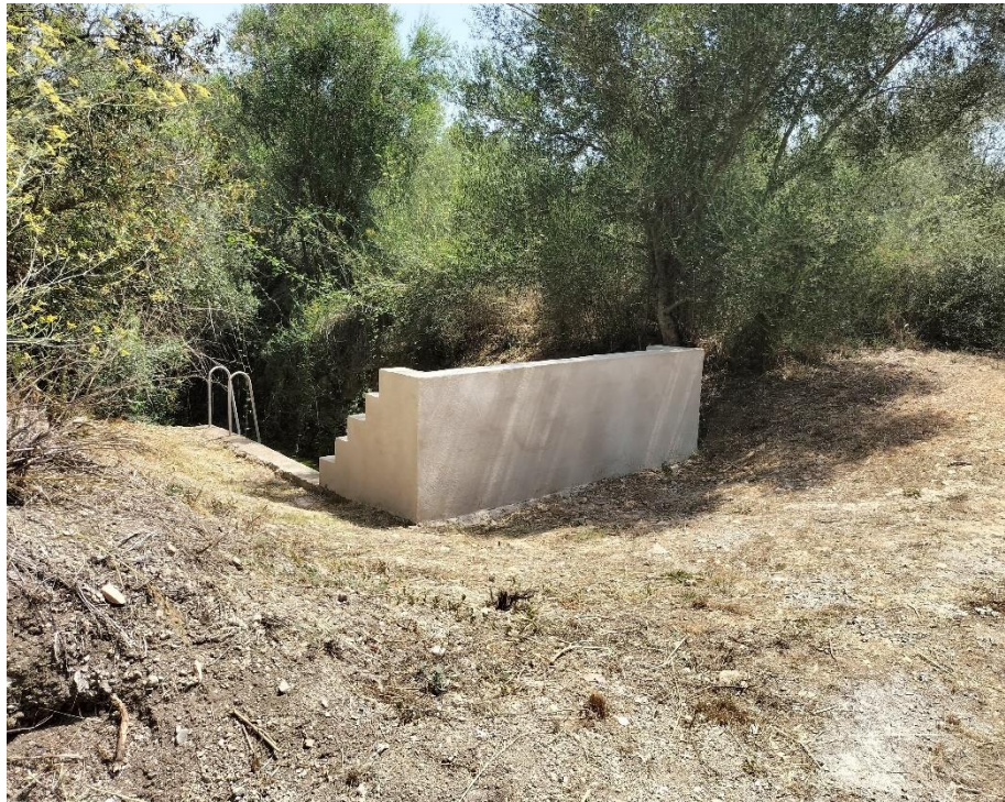
Figura 5 Estado del camino en las inmediaciones del aliviadero
