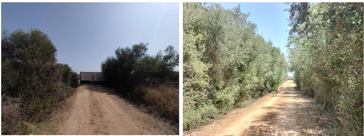
Figura 3 Imágenes del camino existente
