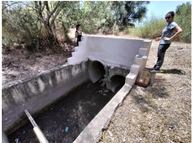
Figura 23 Aliviadero compuesto por dos tubos de hormigón
