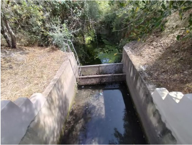
Figura 14 Reja existente en el aliviadero
