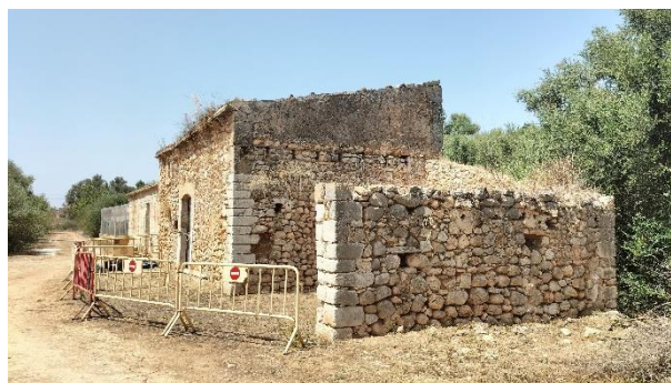
Figura 8 Edificación con piscinas artificiales
