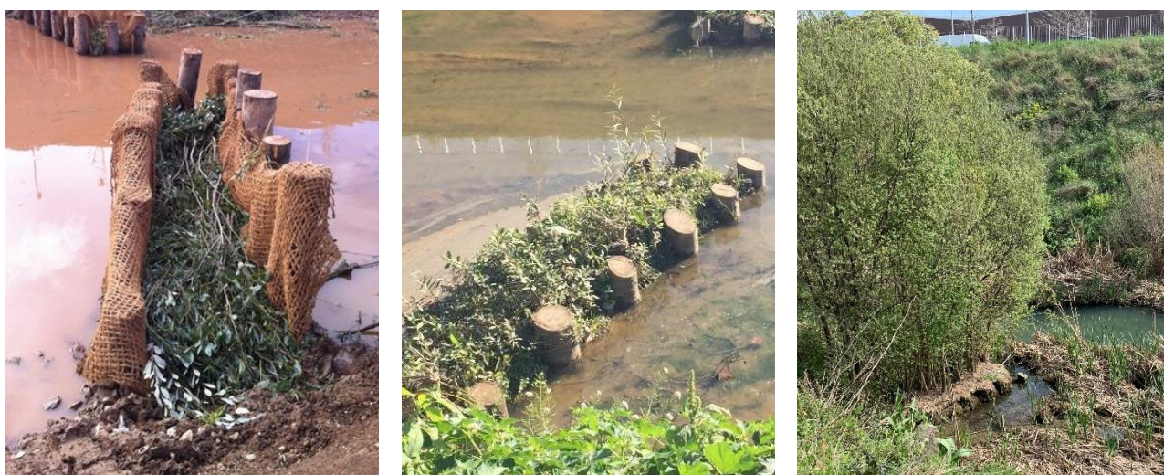
Figura 16 Imágenes del durante y el después de la instalación de una empalizada con madeja de arbustivas Proceso ejecutivo de una empalizada con madeja de arbustivas
