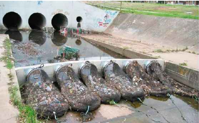
Ejemplo de sistema de retención de flotantes homólogo al definido en el presente proyecto
