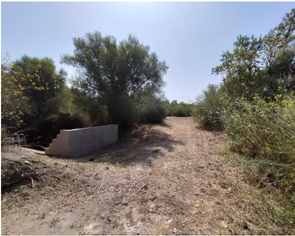
Figura 20 Vista al aliviadero desde el camino principal
