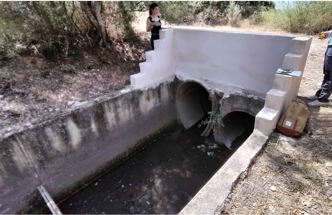
Emboquille del aliviadero
