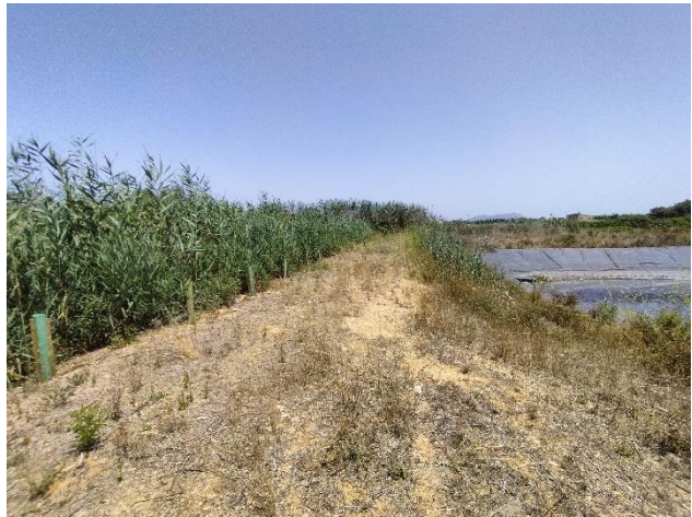
Figura 45 Vista entre la laguna nº1 y la laguna de pluviales
