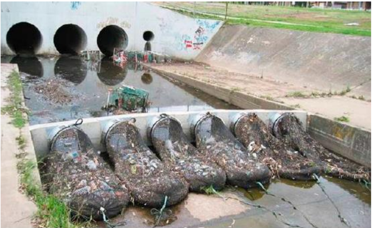
Figura 16 Ejemplo del sistema de retención de flotantes
