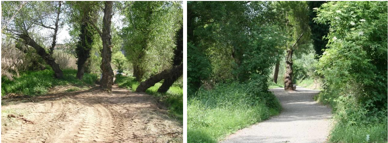
Figura 4 Ejemplo de camino con zahorra (fotos antes y después)
