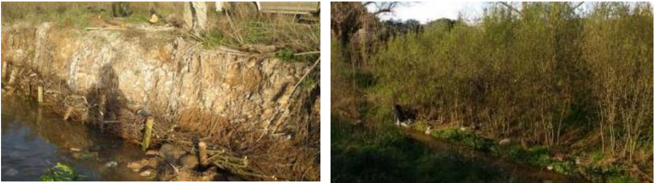
Figura 14 Imágenes de una fajina viva instalada por Naturalea
