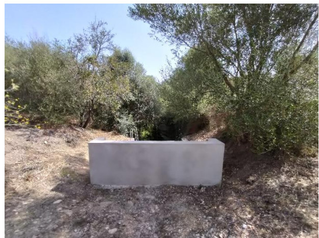
Figura 7 Imagen del muro existente protegiendo el aliviadero
