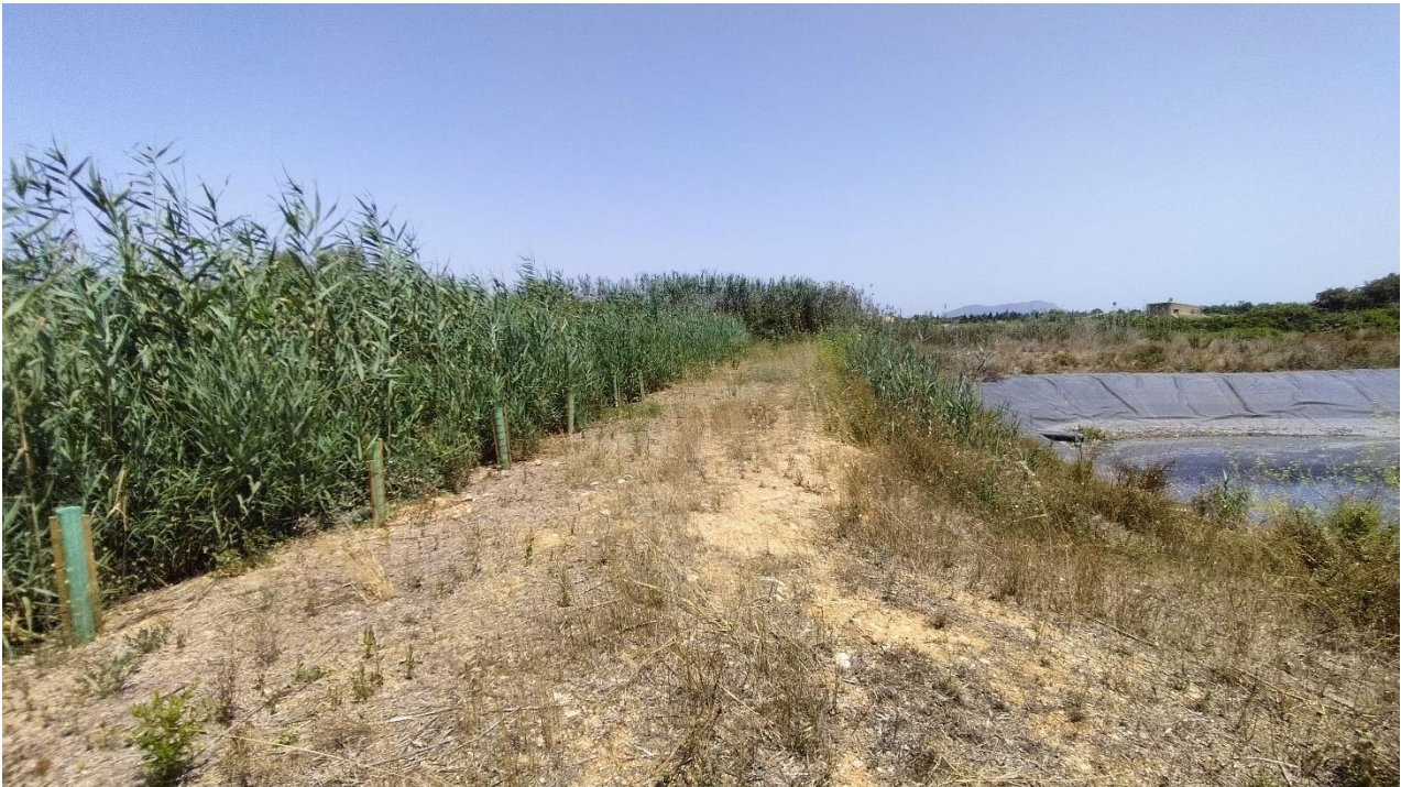
Figura 3 Mota de relleno antrópico entre la laguna de pluviales y la laguna 1 (depresiones de excavaciones antrópicas).
