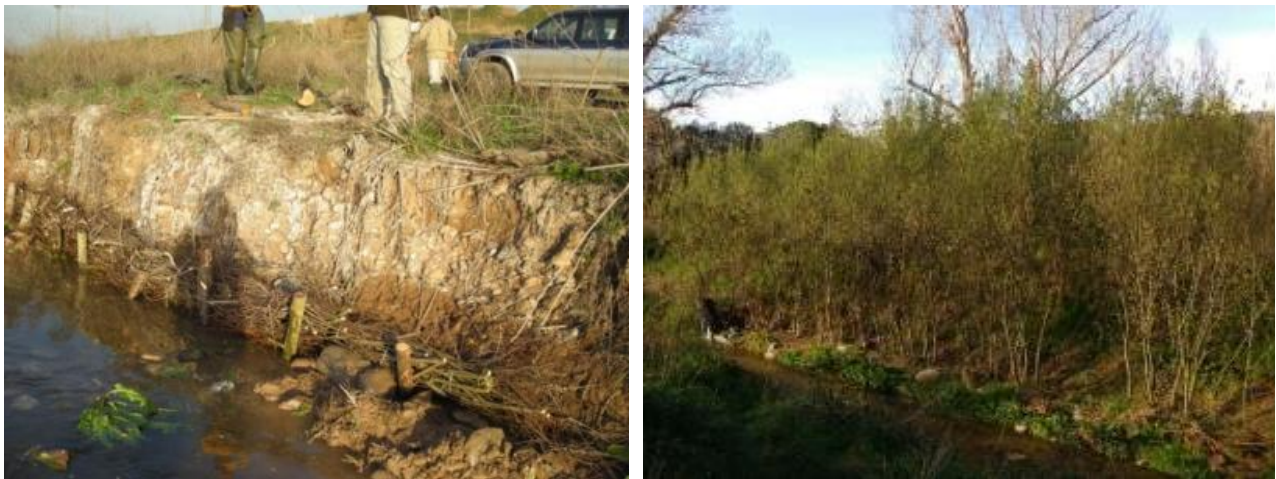
Figura 1 Imágenes de una fajina viva instalada por Naturalea
