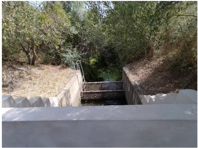
Figura 21 Aliviadero rodeado de un muro de obra
