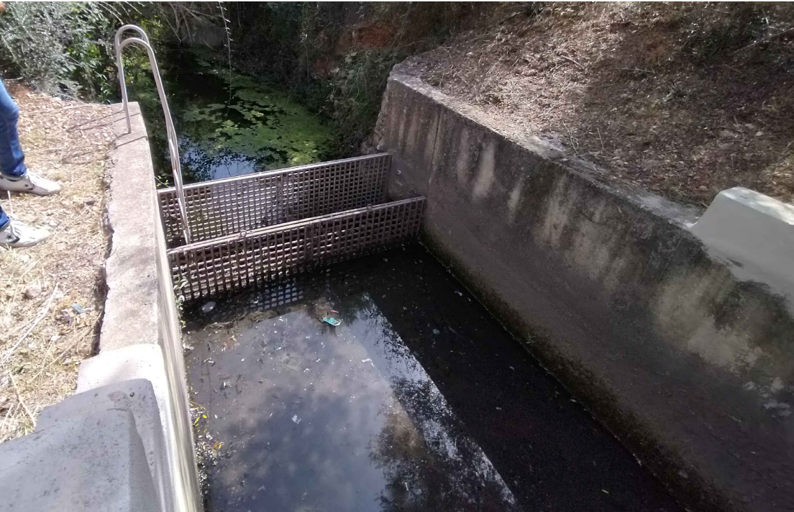
Rejas de retención de flotantes existentes aguas abajo del aliviadero
