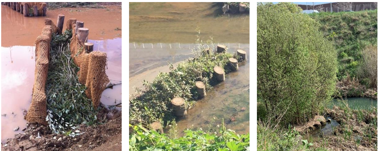
Figura 3 Imágenes del durante y el después de la instalación de una empalizada con madeja de arbustivas Proceso ejecutivo de una empalizada con madeja de arbustivas
