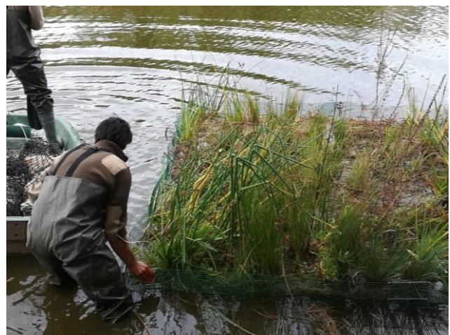
Figura 9 Proceso de instalación de la isla flotante
