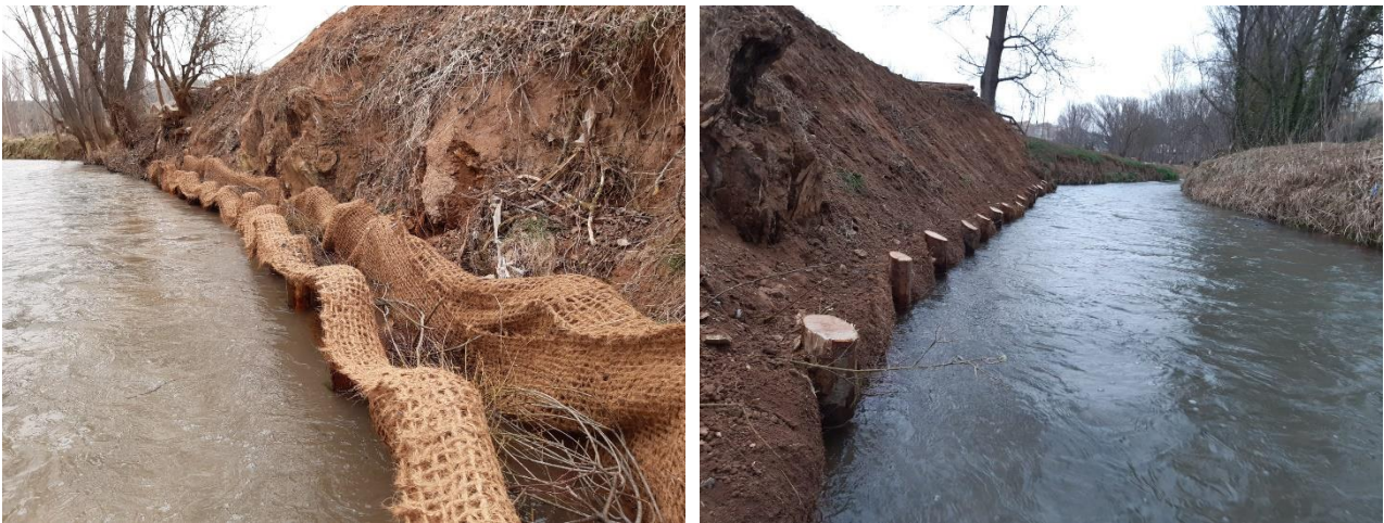
Figura 23 Imágenes de la instalación de una empalizada con madeja de arbustivas
