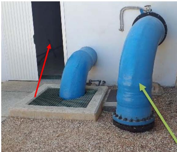
Codo exterior del colector de Rebose y Vaciado
