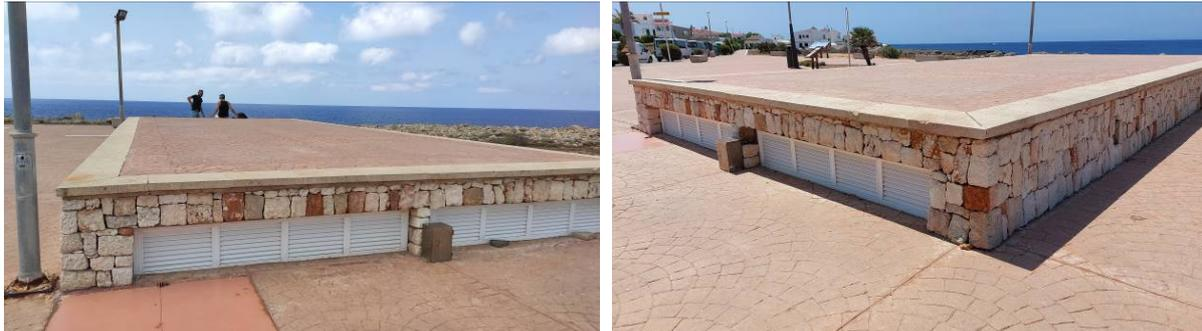
En días de lluvia moderadas o intensas, que coinciden con días de viento, provenientes del norte como son la tramuntana, el agua llega a penetrar por las rejillas de ventilación de las ventanas blancas que vemos en las imágenes anteriores.
