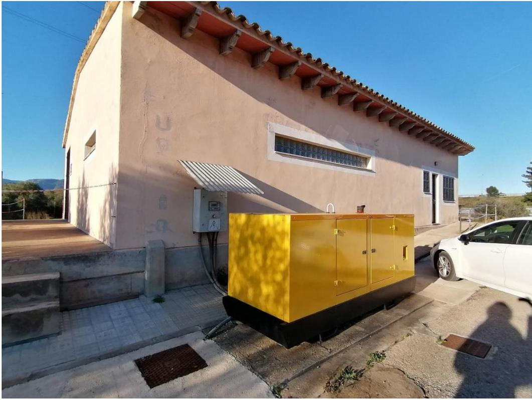
*Figura 8. Vista de la actual EDAR. Detalle grupo electrógeno.*
