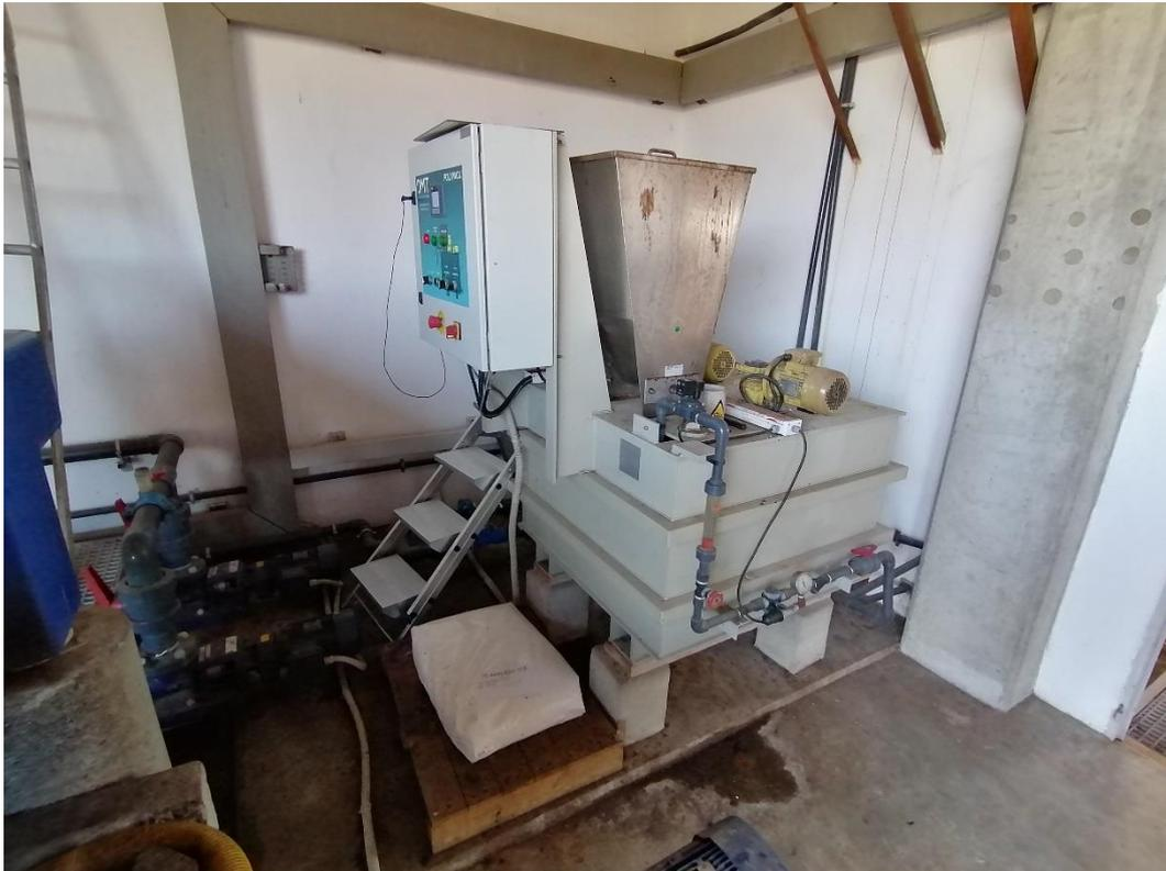
Figura 20. Vista de la actual EDAR. Equipo de preparación del polielectrolito.
