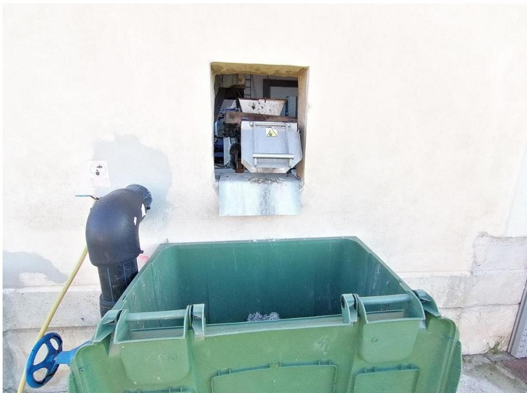
Figura 13. Vista de la actual EDAR. Detalle del equipo de compactación residuos.
