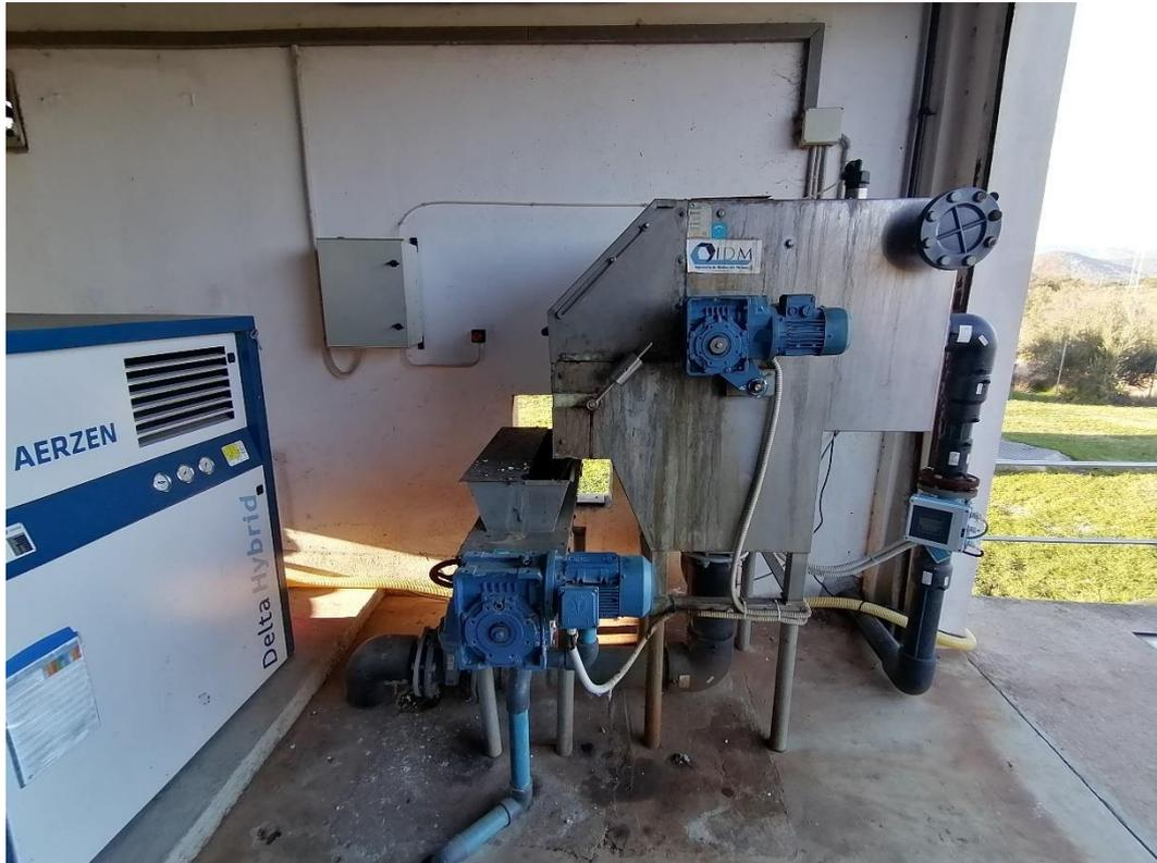
Figura 12. Vista de la actual EDAR. Detalle del equipo de tamizado.
