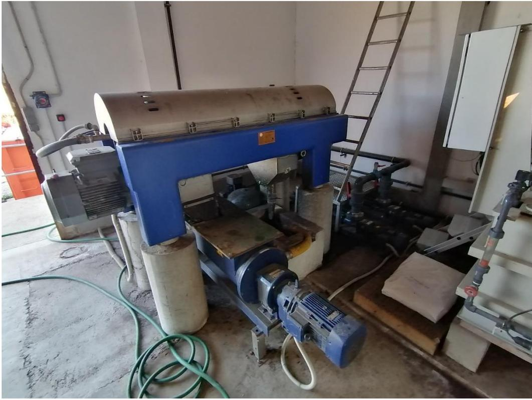
Figura 22. Vista de la actual EDAR. Deshidratación de fangos: Centrífuga.
