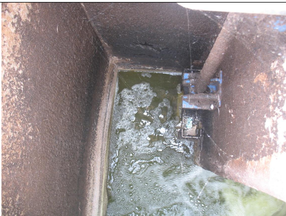
FOTO N°52 Pozo de salida.
