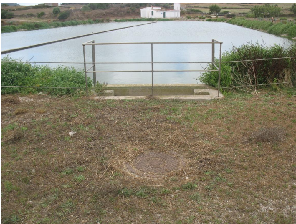
FOTO N°40 Laguna III. Cámara para compuerta de salida de la Laguna III a la Laguna de decantación-afino (Laguna IV).
