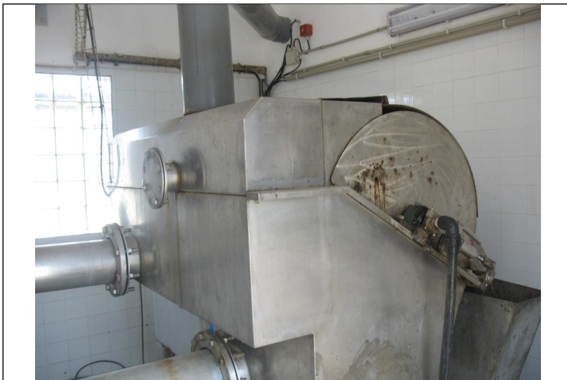
FOTO Nº21 Tamiz de finos para las aguas del núcleo de Es Mercadal.
