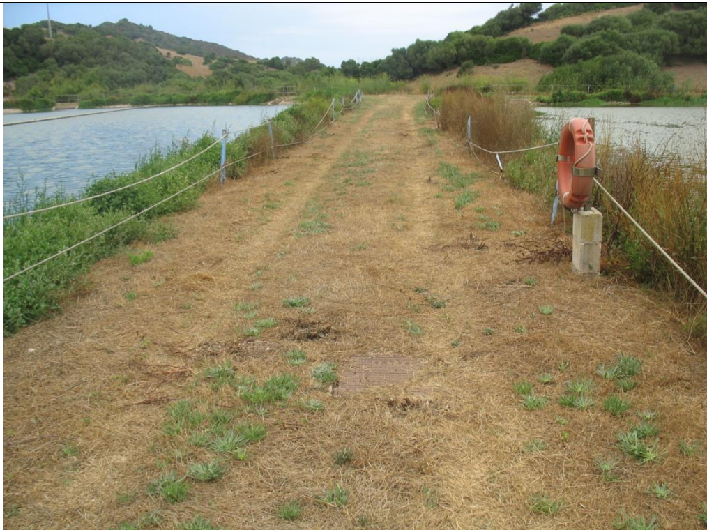
FOTO N°36 Vial entre las lagunas de sedimentación n° 1 y n° 2 (Laguna III).
