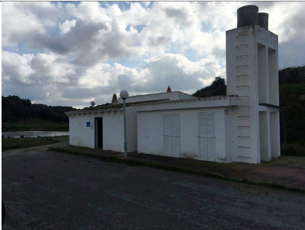
FOTO N°59 Edificios en entrada.
