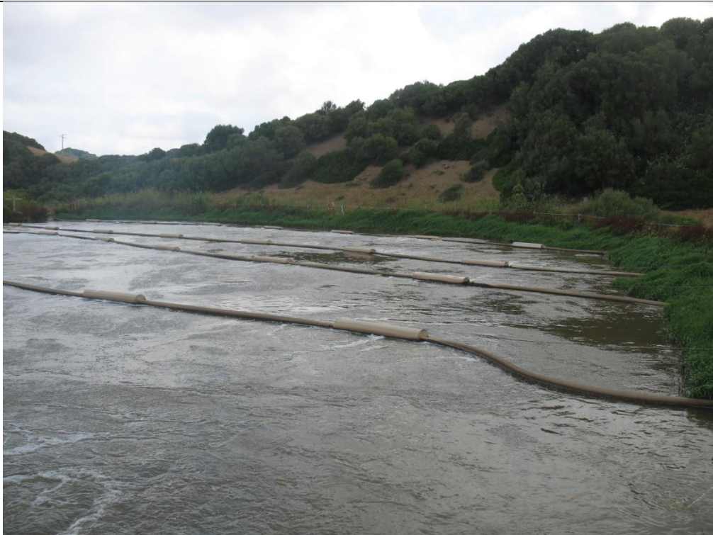
FOTO Nº17 Laguna de aireación (Laguna I).
