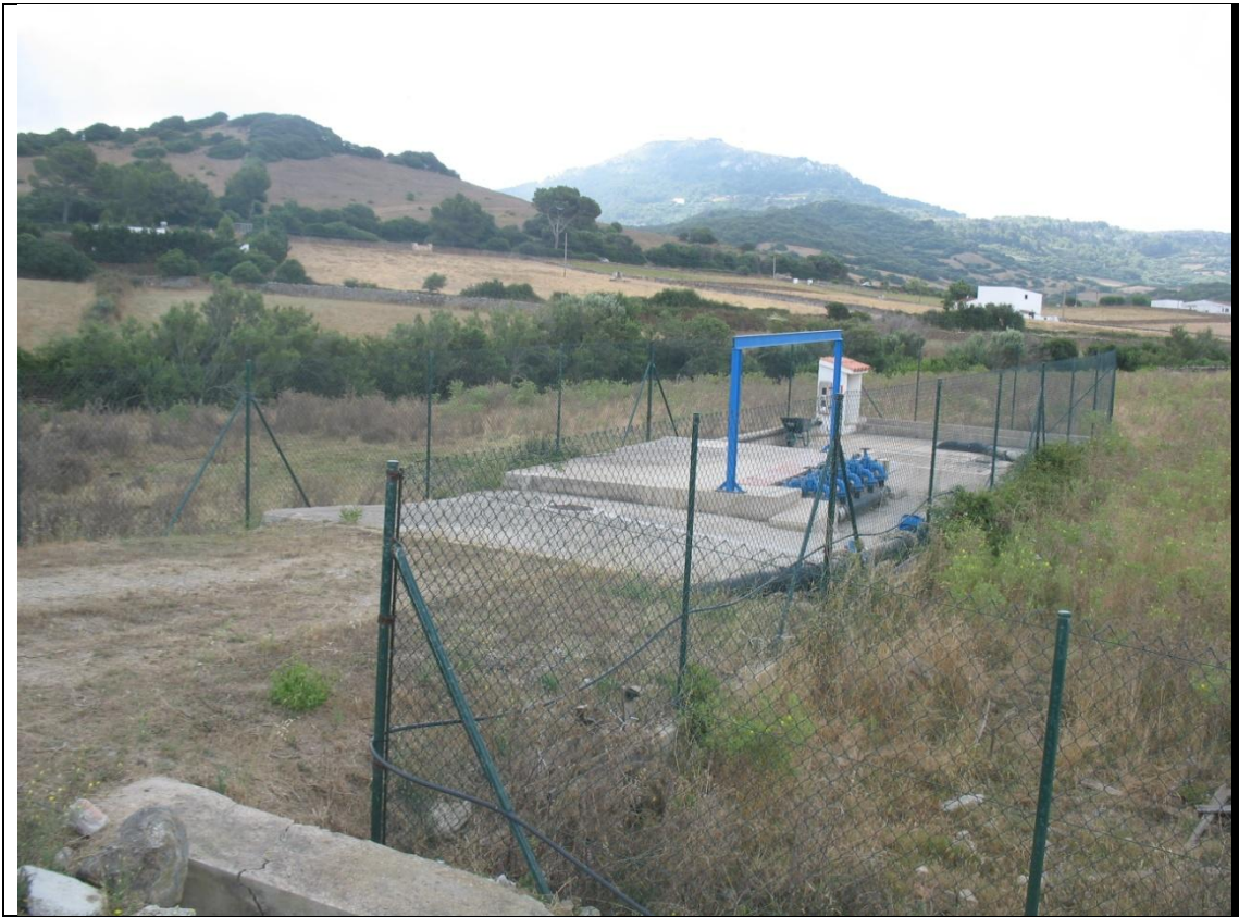
FOTO Nº3 Vista general de la zona de entrada de agua bruta.
