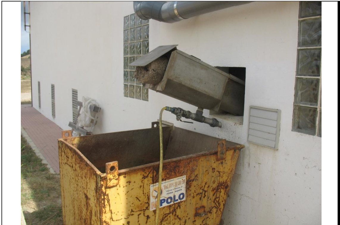
FOTO N°23 Contenedor de residuos del tamizado.
