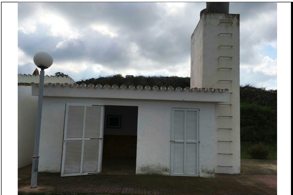
FOTO N°64 Entrada a edificio almacén.
