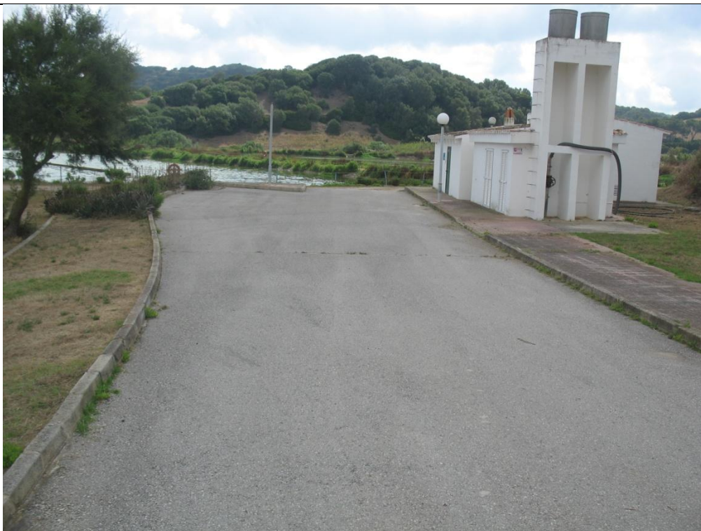
FOTO Nº2 Edificio de explotación y control, almacén, aseos y grupo electrógeno.
