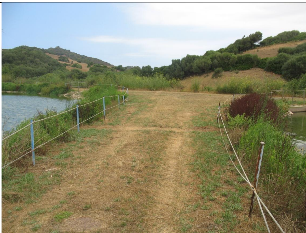
FOTO Nº37 Vista de la zanja de tubería de paso de la Laguna de sedimentación nº 1 a la nº 2.
