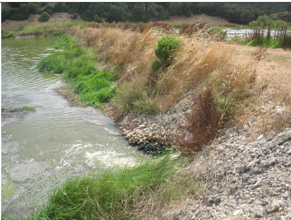
FOTO Nº34 Vertido del agua de la Laguna de Aireación a la Laguna de sedimentación nº 1 (Laguna II).
