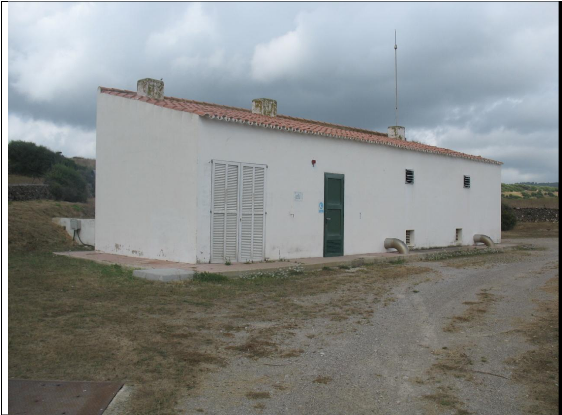
FOTO Nº19 Edificio de soplantes y del tamiz del agua procedente del núcleo de Es Mercadal.
