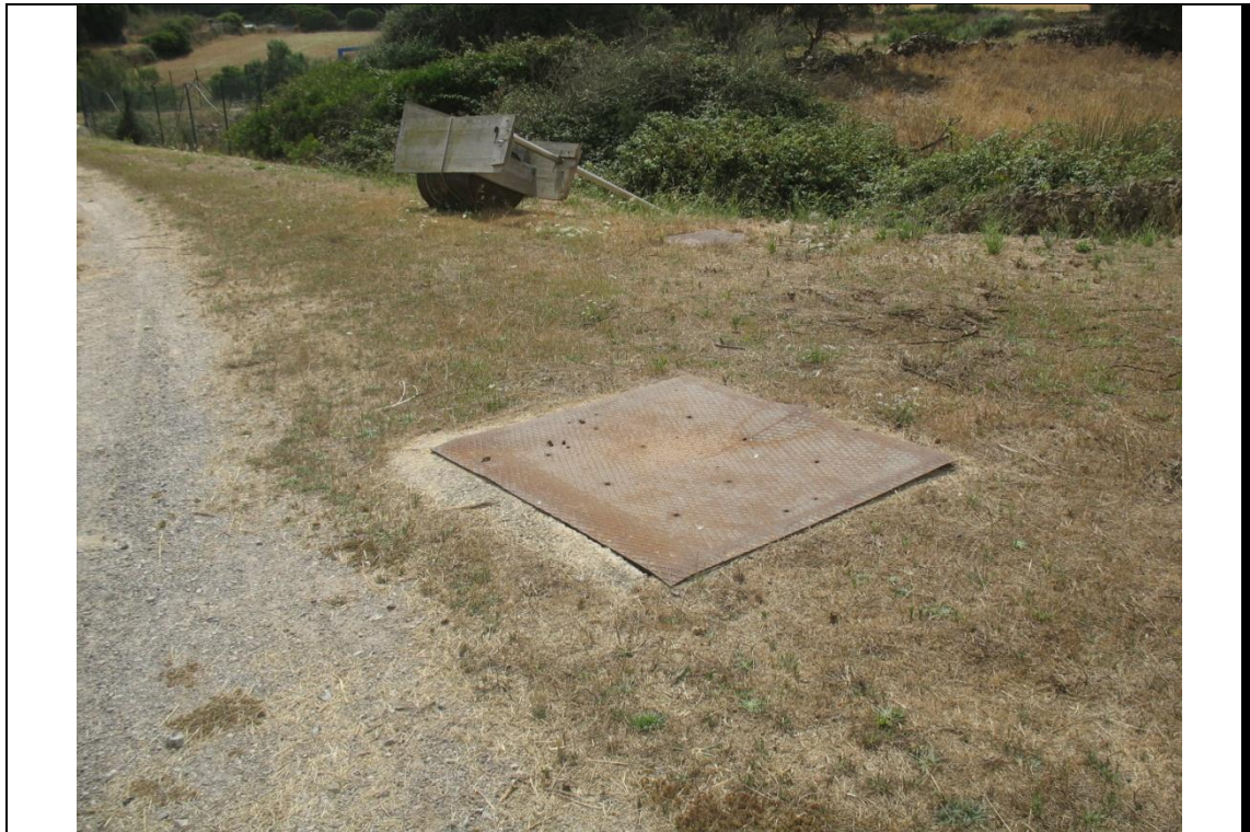
FOTO N°24 Arqueta para caudalímetro de las aguas del núcleo de Es Mercadal.
