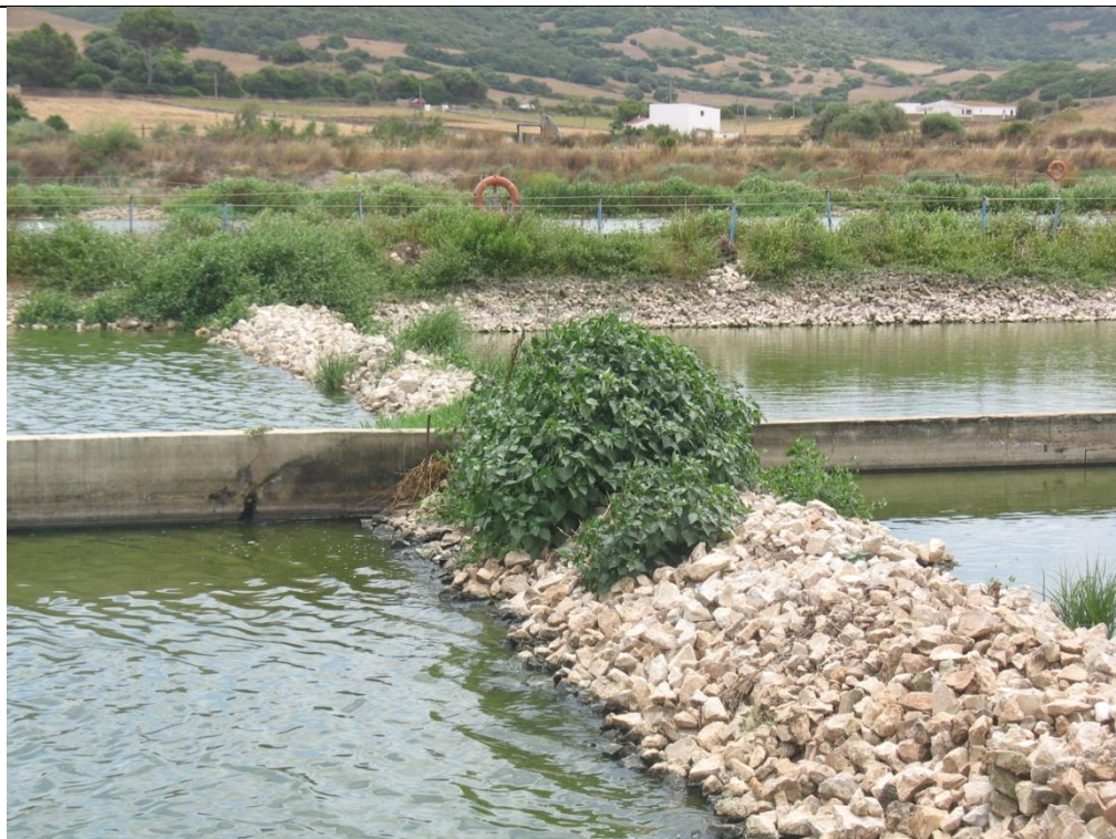
FOTO Nº46 Detalle de los distintos niveles de agua en la Laguna IV.
