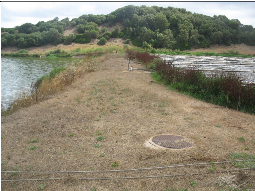
FOTO Nº33 Vial entre la Laguna de aireación y la Laguna de decantación nº 1. Pozo de registro de tubería de paso del agua de una laguna a la otra
