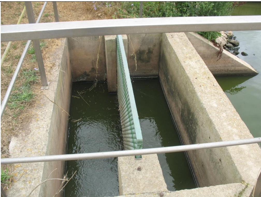
FOTO N°44 Reja en cámara de salida de la Laguna IV.
