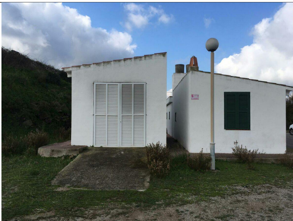
FOTO N°60 Edificios en entrada. Puerta de entrada del edificio de grupo electrógeno
