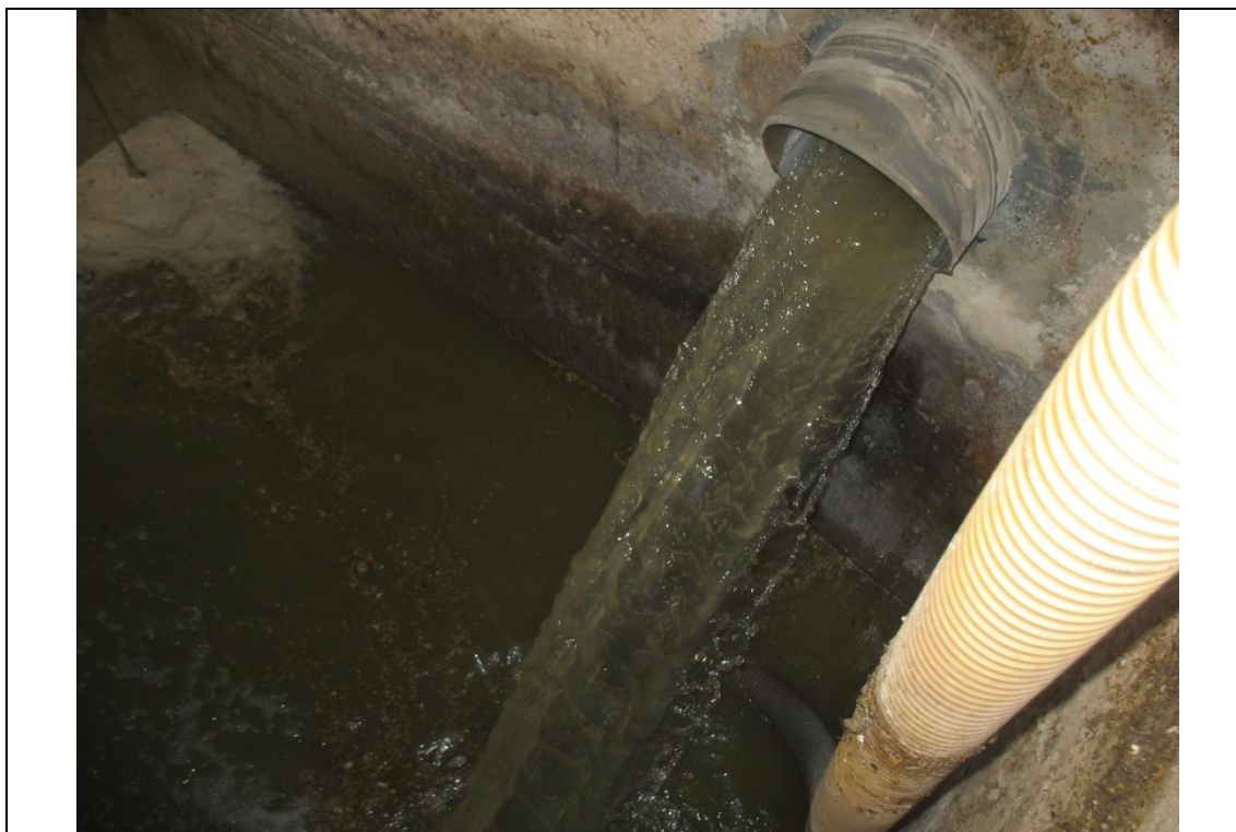
FOTO Nº10 Detalle de la entrada al pozo de bombeo.
