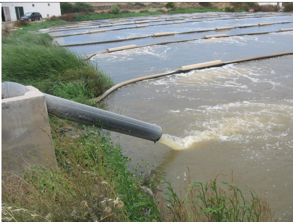
FOTO Nº16 Salida del tamiz del agua de Sta Victòria a la Laguna de aireación.
