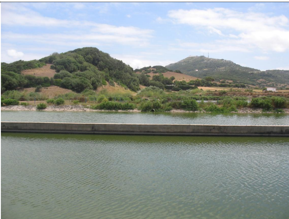
FOTO Nº38 Laguna de sedimentación nº 2 (Laguna III). Tubería de entrada al fondo.
