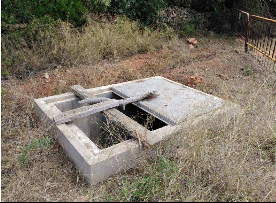
FOTO N°7: Arqueta donde se ha realizado la conexión de la tubería nueva de PEAD DN315 con la conducción existente.
