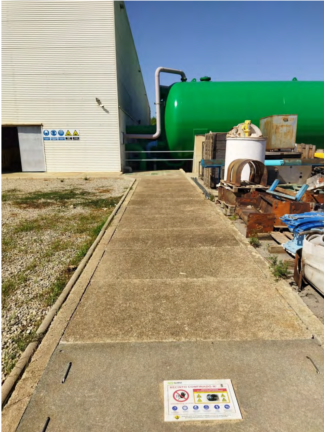
Llegada de agua bruta
