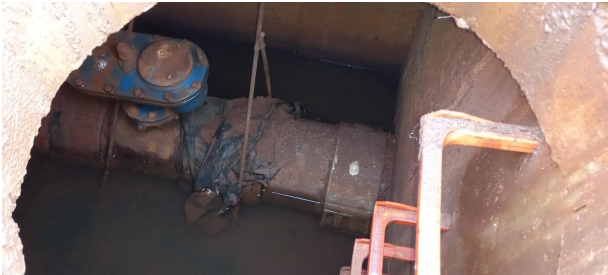
Ilustración 5.- Interior Ventosa N°1
