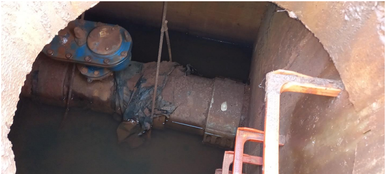
Ilustración 4.- Interior Ventosa N°1
