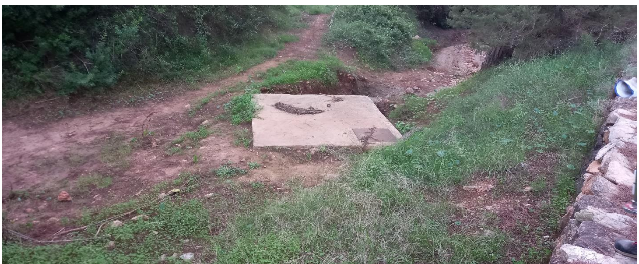
Ilustración 6.- Vista General de la losa superior de la arqueta en el Torrente de Labritja
