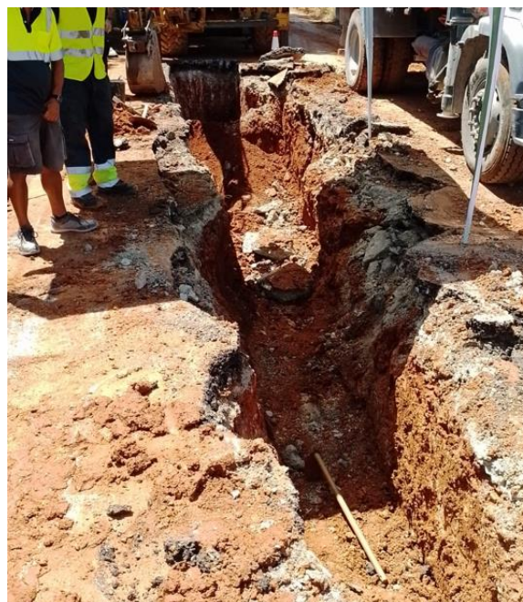
Ilustración 17 y 18. Trazado de la tubería PRFV DN 400 mm actualmente en servicio. Se puede observar la presencia de un terreno compacto generalmente estable.
