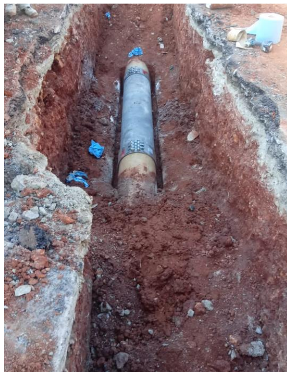
Ilustración 19 y 20. Trazado de la tubería PRFV DN 400 mm actualmente en servicio. Se puede observar la presencia de un terreno compacto generalmente estable.
