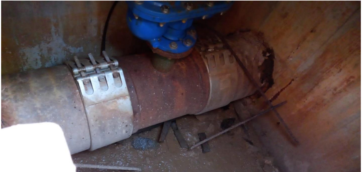
Ilustración 6.- Interior Ventosa N°3
