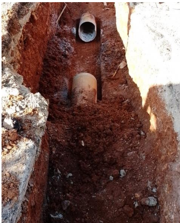
Ilustración 19 y 20. Trazado de la tubería PRFV DN 400 mm actualmente en servicio. Se puede observar la presencia de un terreno compacto generalmente estable.
