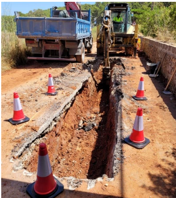
Ilustración 17 y 18. Trazado de la tubería PRFV DN 400 mm actualmente en servicio. Se puede observar la presencia de un terreno compacto generalmente estable.
