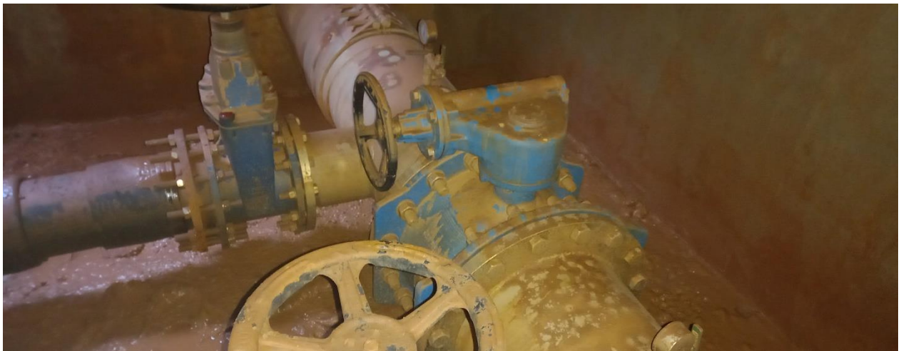
Ilustración 7.- Interior de la arqueta donde se puede observar el estado actual de los accesorios instalados y el tramo de desagüe
