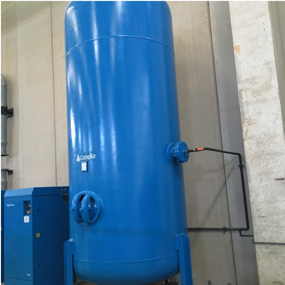
Foto 29 Depósito aire comprimido 6.000 l 14,3 bar, servicios.
