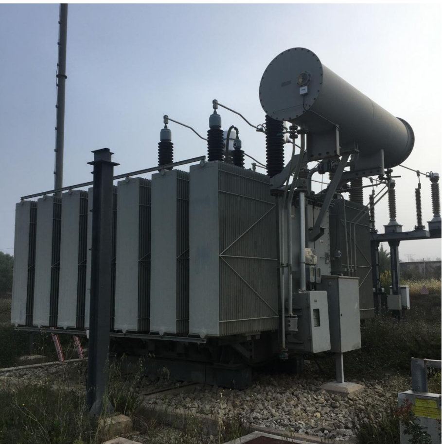
Foto 51 Trafo nº 3 40 MVA 132/15 KV que sustituye a trafo 31,5 MVA fuera de uso.
