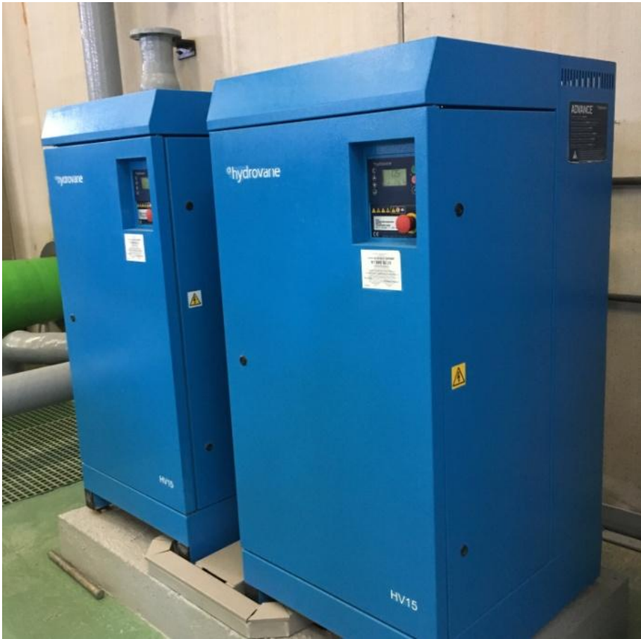
Foto 28 Compresores para aire de servicio hydrovane 15 kW c/u
