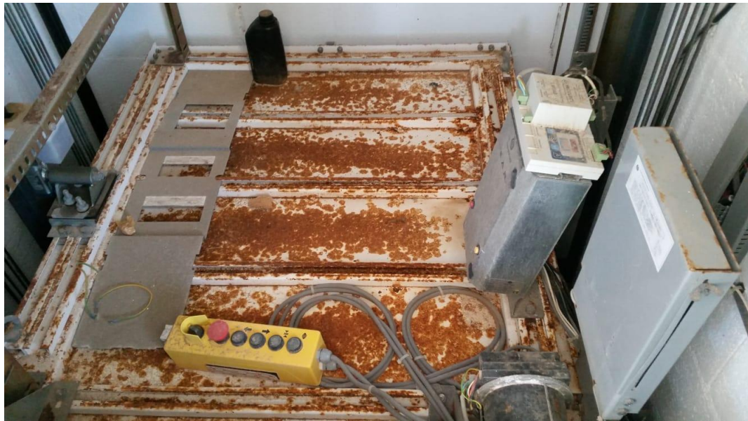
Foto 41 Techo de ascensor.
