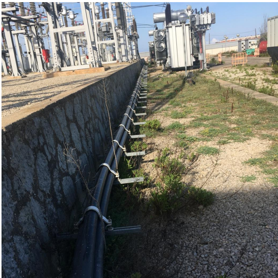
Foto 50 Detalle línea conductores aislados de 3 x 1 x 1200 mm 2 desde calle existente hasta trafo Nº 3 40 MVA.
