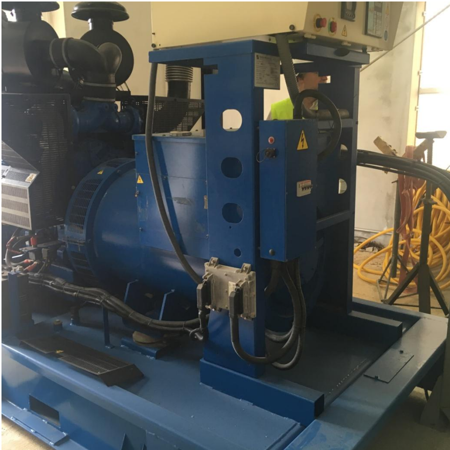
Foto 38 Grupo electrógeno IDAM de 455 KVA.
