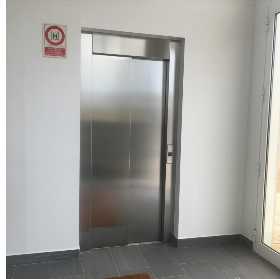
Foto 40 Puerta de acceso a ascensor desde planta B.
