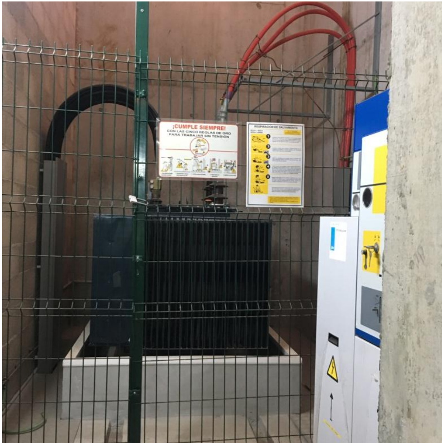
Foto 10 Transformador 1250 KVA en instalación subterránea de Cantara
