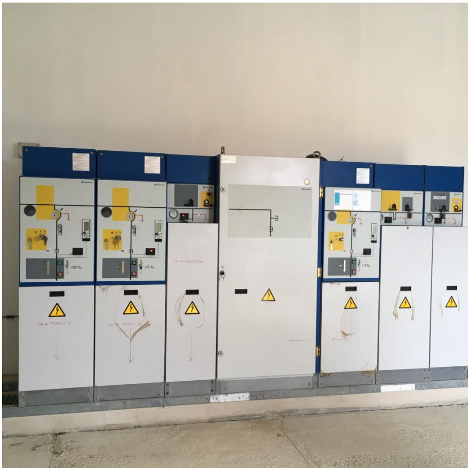
Foto 44 Aparamenta Media Tensión I.D.A.M.
