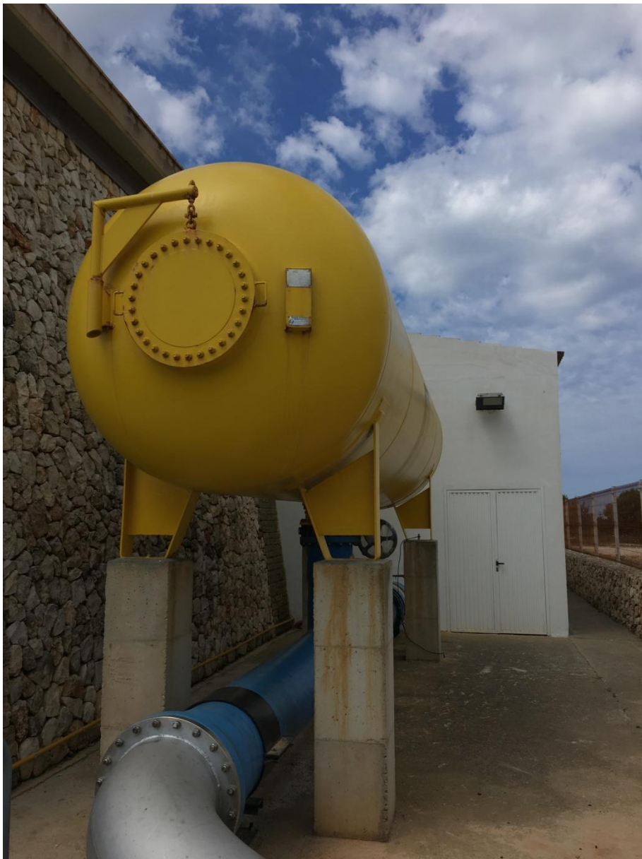
Foto 32 Equipo anti ariete bombeo agua tratada a depósitos municipales.
