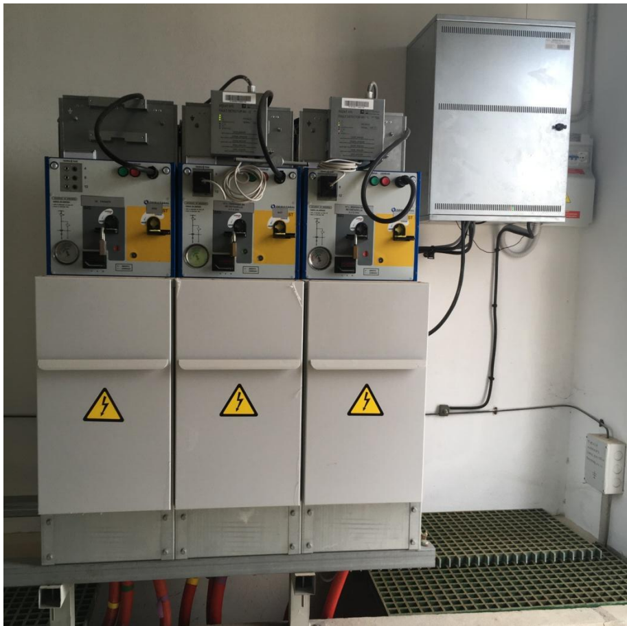
Foto 43 Celdas entrada/salida y remonte para telemando.
