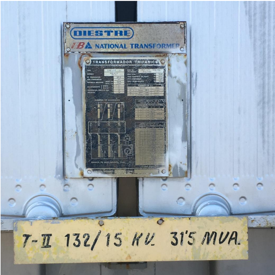
Foto 48 Placa de características trafo 31,5 MVA (año 1991)
