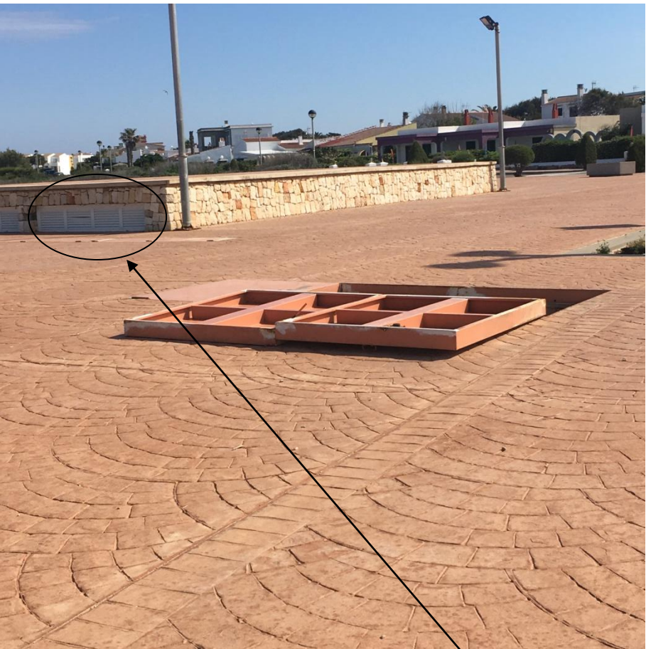
Foto 12 Cubierta de maquinaria en zona cantara y rejillas de ventilación
